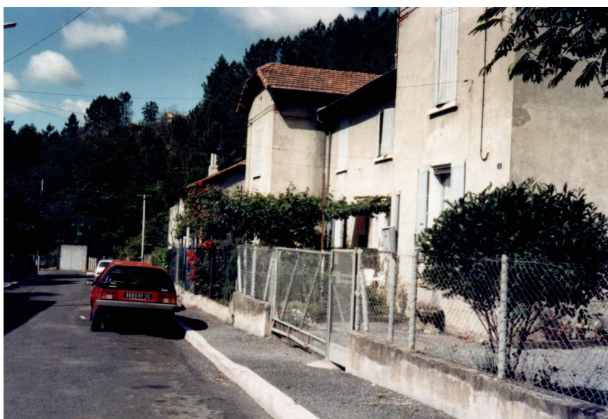
FOTO 7: RESIDÊNCIA FAMÍLIA COURDEC, CASAS GEMINADAS COM JARDIM NA FRENTE E PÁTIO NOS FUNDOS.
