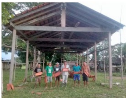
CCS em construção em Barreirinha (AM)
